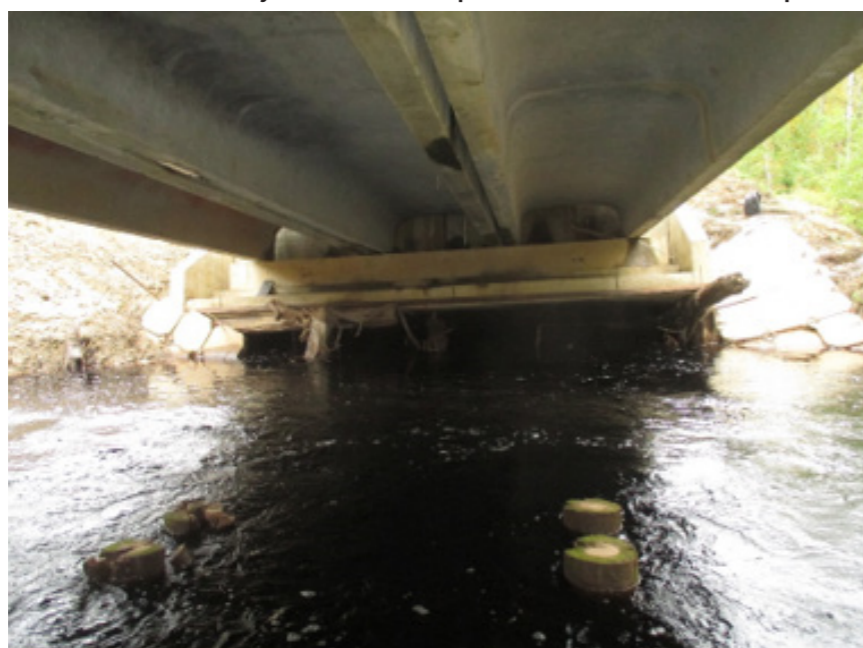
Рисунок 3. Не срезанные стойки деревянного моста и установка конструкций диванного устоя на деревянные конструкции старого моста.
