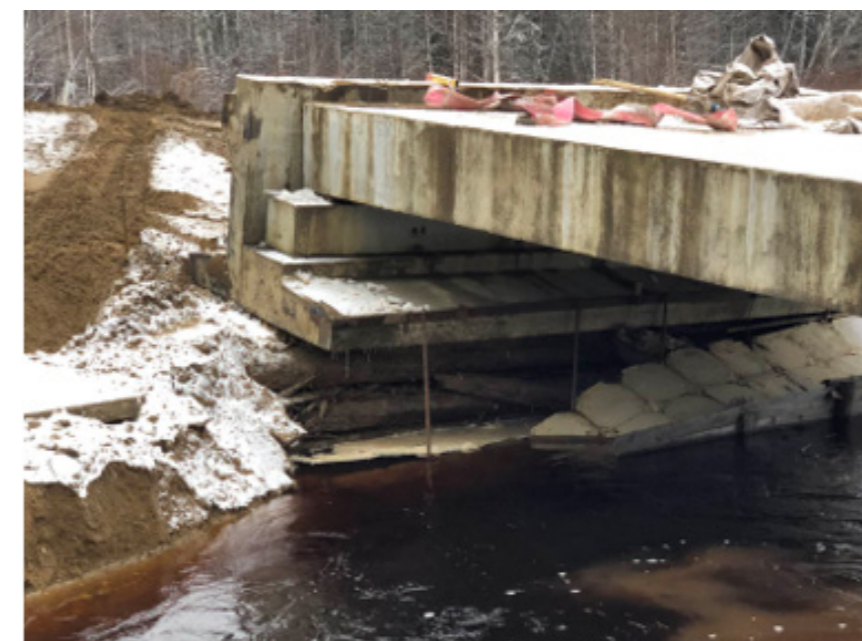
Рисунок 4. Отсутствие закрепления откосов устоев.
